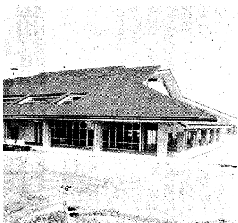
▲ほぼ完成した公園センター
