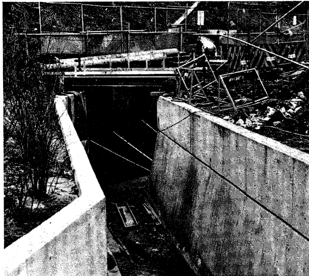
すすむ西宇治都市下水道工事(広野町桐生谷付近)
