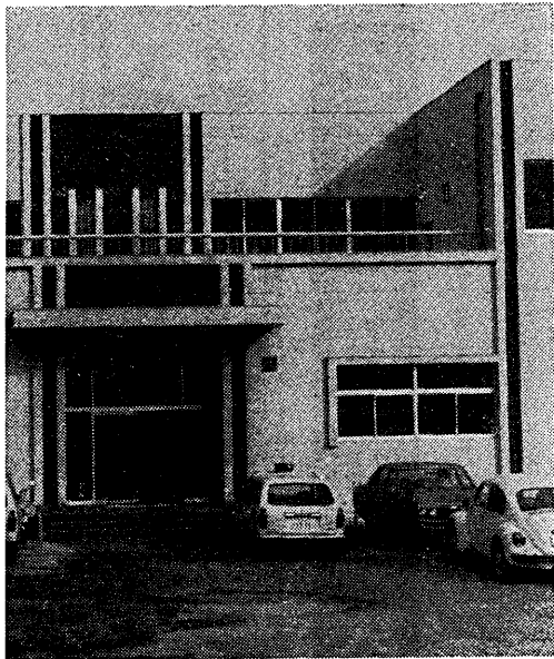
新築なった宇治浄水場管理本館
