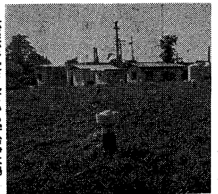
拡張が予定されている宇治浄水場
