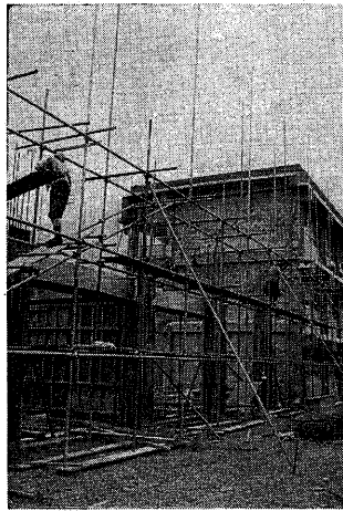
47年度に開校した北宇治中も、はや増築工事
