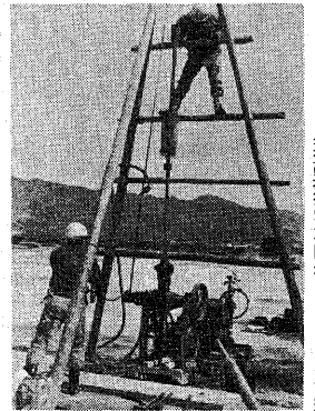
工場建設の現場
