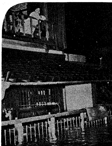
二度の水害に見舞われた六地藏・木幡地区 （6月・10月）
