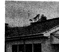
木造平家建、日本瓦ぶき25.5坪外壁ラスタ下地モルタルぬり。内部は木づくり下地ソツクリ壁で、工費は419,000円です。(写真は善法集会所)
