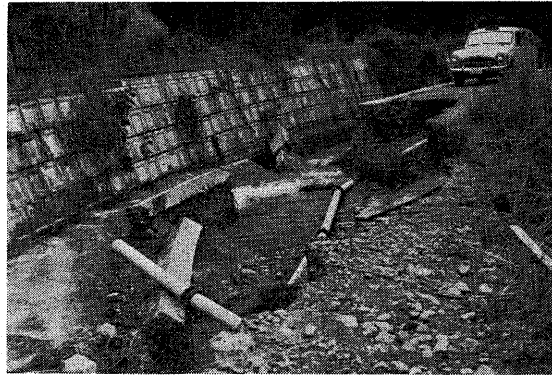
↑ 宇治川いま漏水、必死の水防作業(大曲堤防) ← むきだしにされた水道幹線 (菟道)
