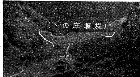
① 下の庄堰堤工事(災害土木事業) 工費 四、〇三五〇〇〇円 延長四十五米、堰高約十米
