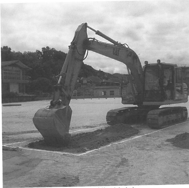
重機掘削（北西より）
