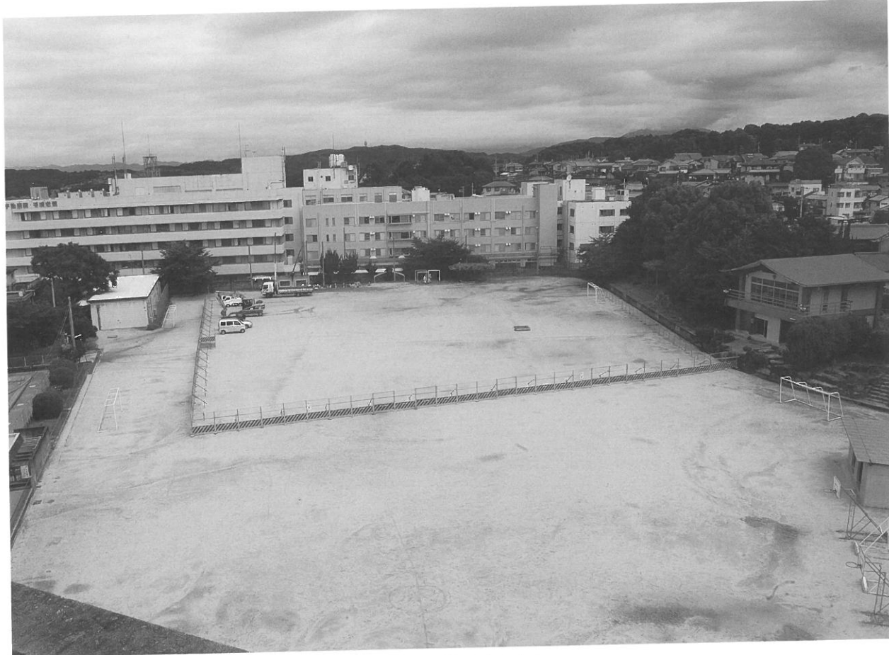
掘削前現地（南より）
