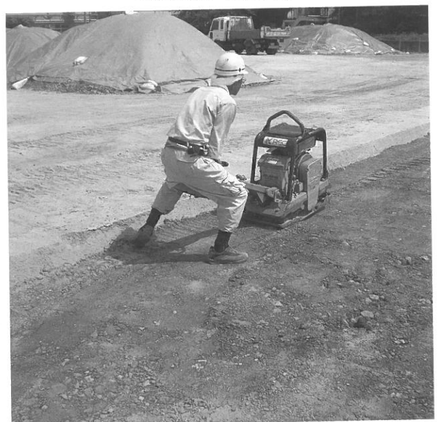
現状復旧（南西より）
