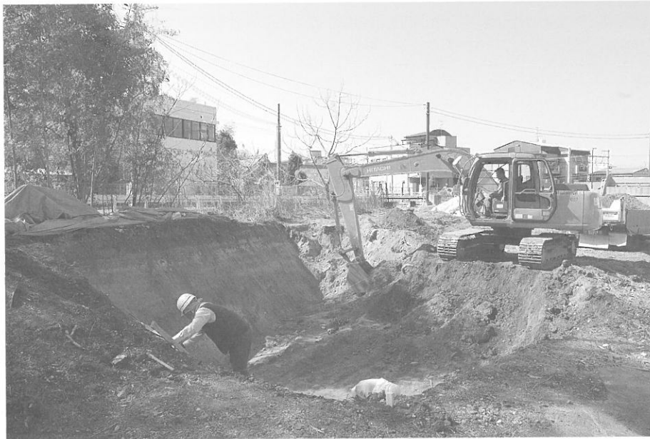
重機掘削（北東より）
