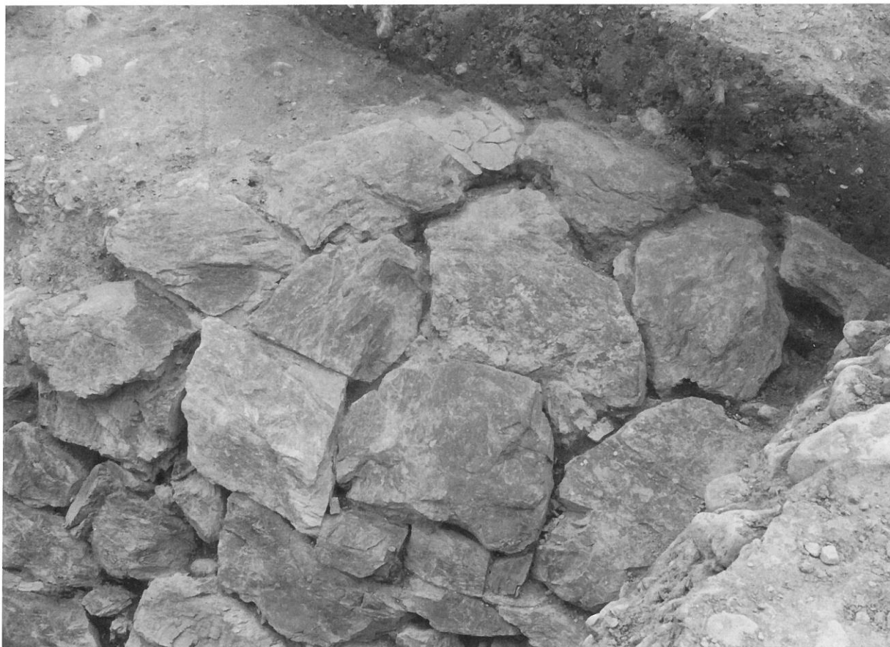
1. 護岸遺構 SX01 石出し 3 天端部分石張り (北西から)
