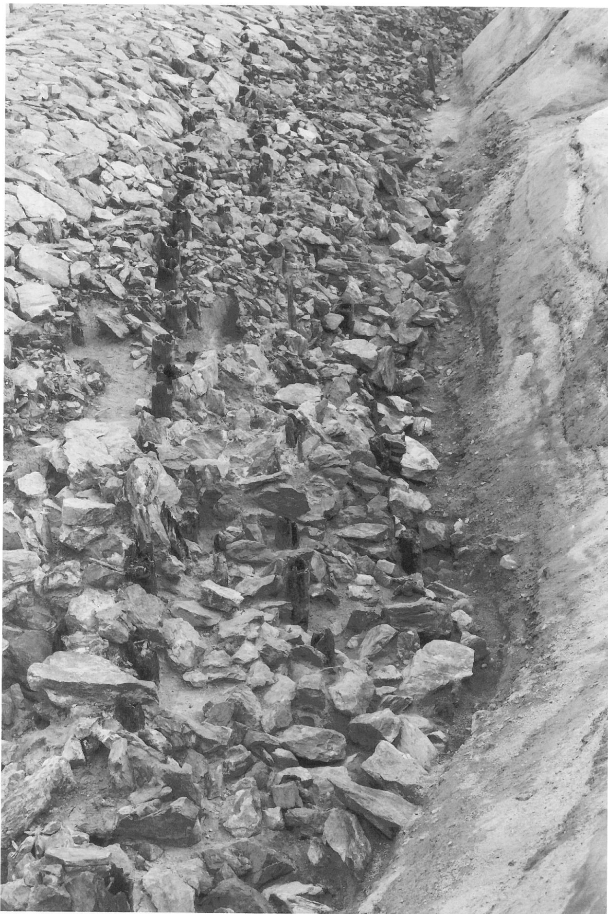
護岸遺構 SX01 杭出し 1 (北西から)
