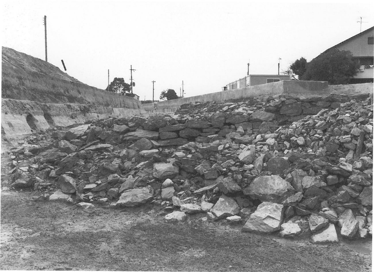
2. 護岸遺構 SX01 石出し 1 上流側石垣 (南から)
