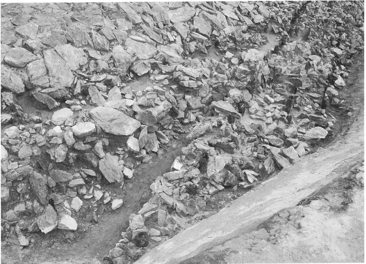
2. 護岸遺構 SX01 杭出し 1 護岸との接続部 (北西から)
