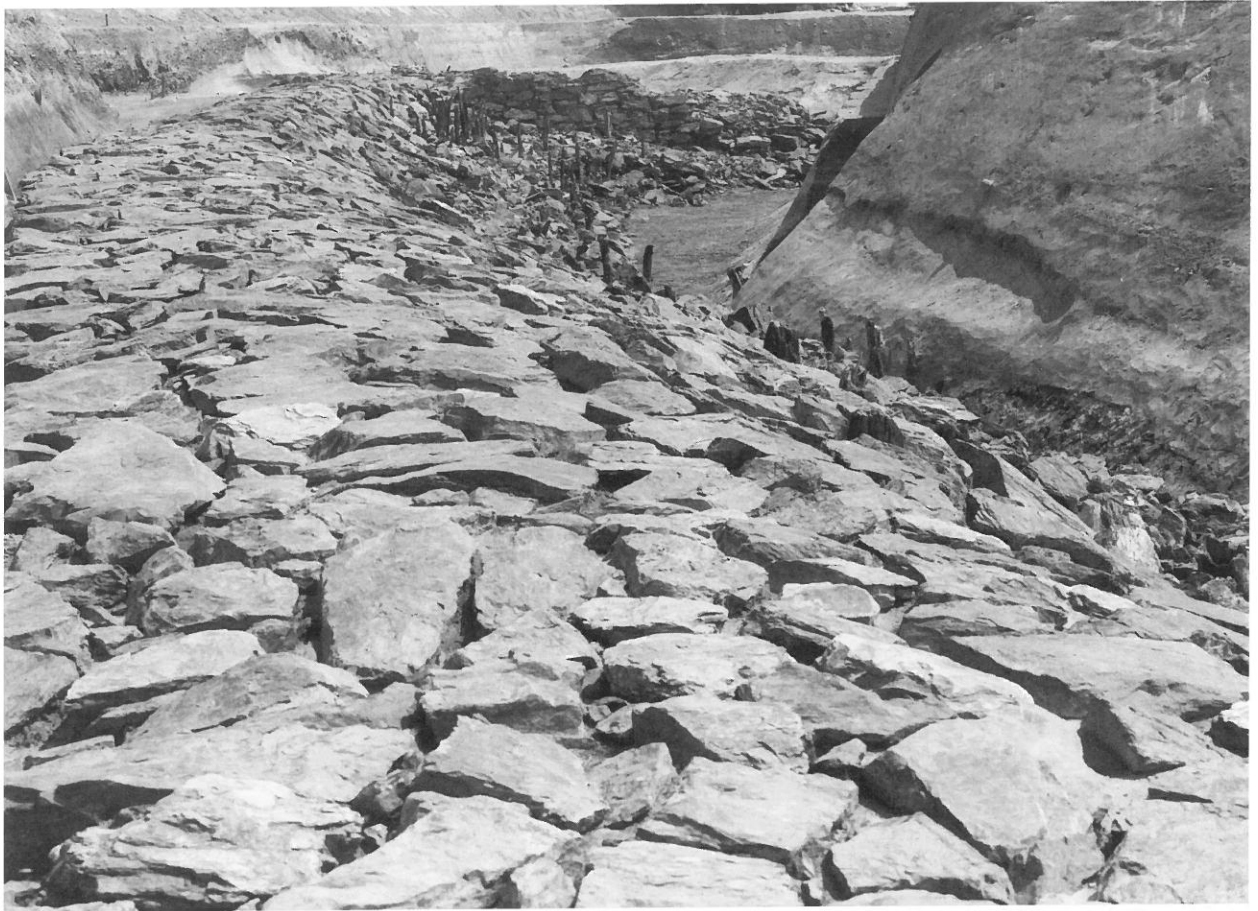
1. 護岸遺構 SX01 石張り状況 (北から)
