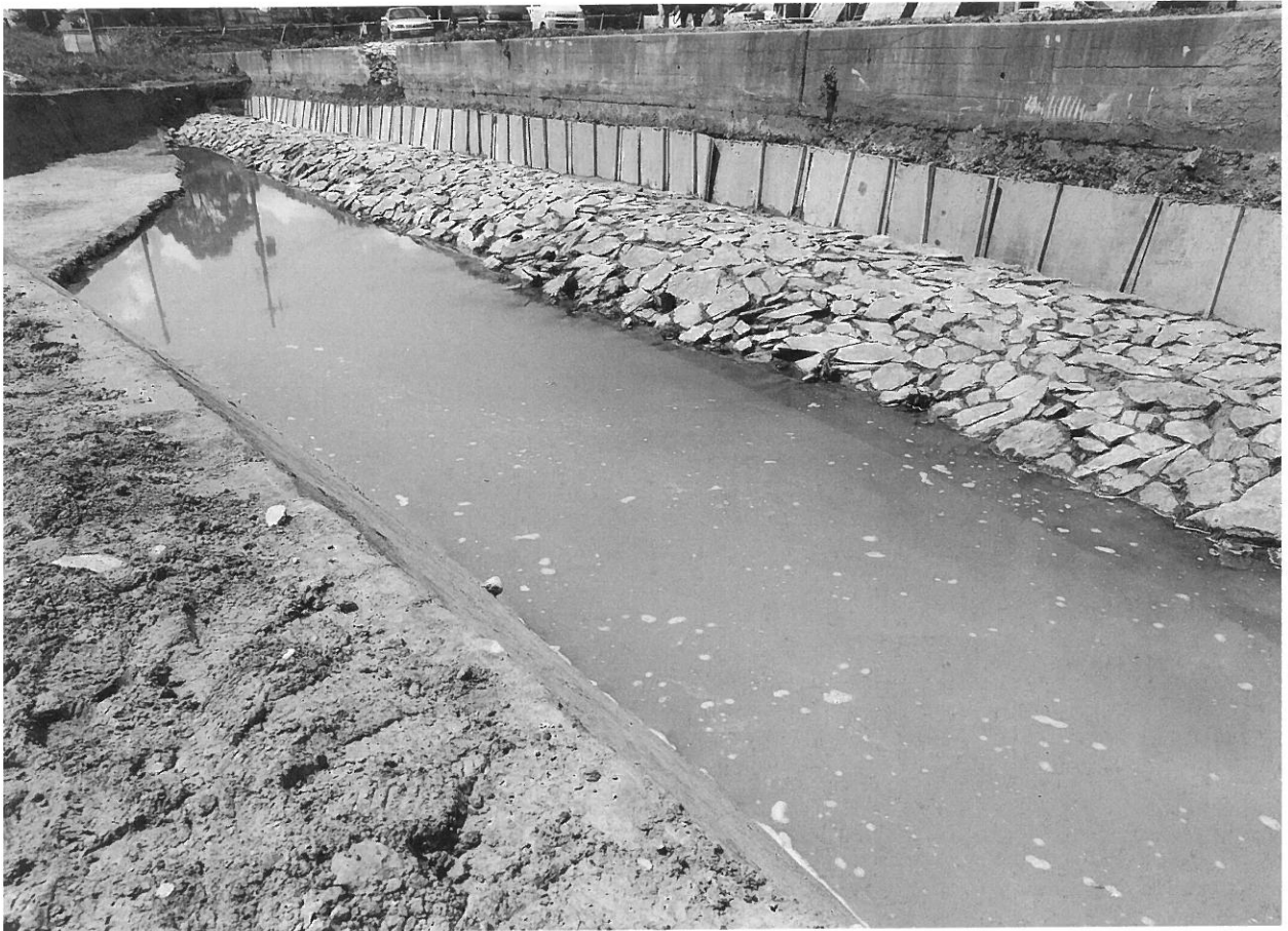
2. 護岸遺構 SX01 注水状況 (南西から)
