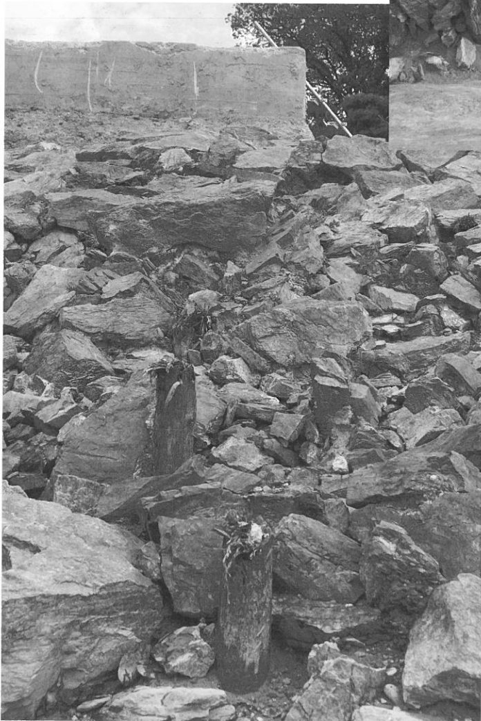
2. 護岸遺構 SX01 石積み状況 (西から)
