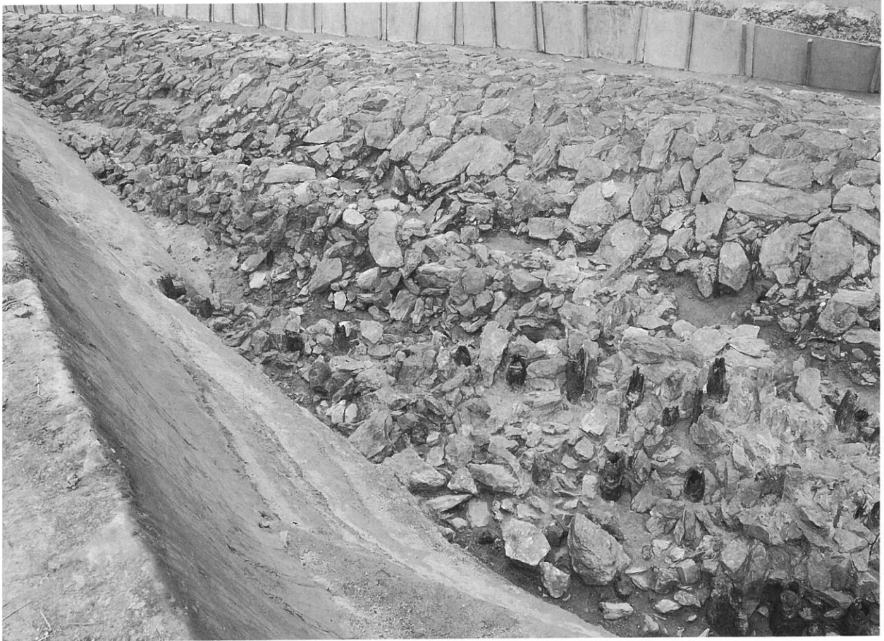
1. 護岸遺構 SX01 石張り・石積み状況 (南西から)
