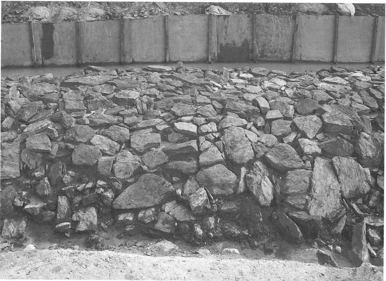
2. 護岸遺構 SX01 石張り状況 (西から)
