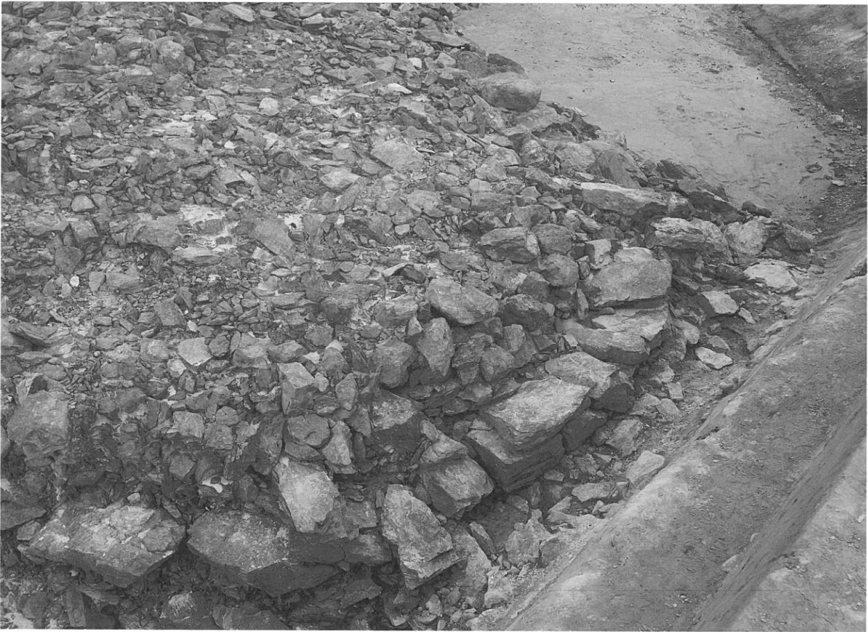
1. 護岸遺構 SX01 石出し 1 先端部石垣 (北西から)
