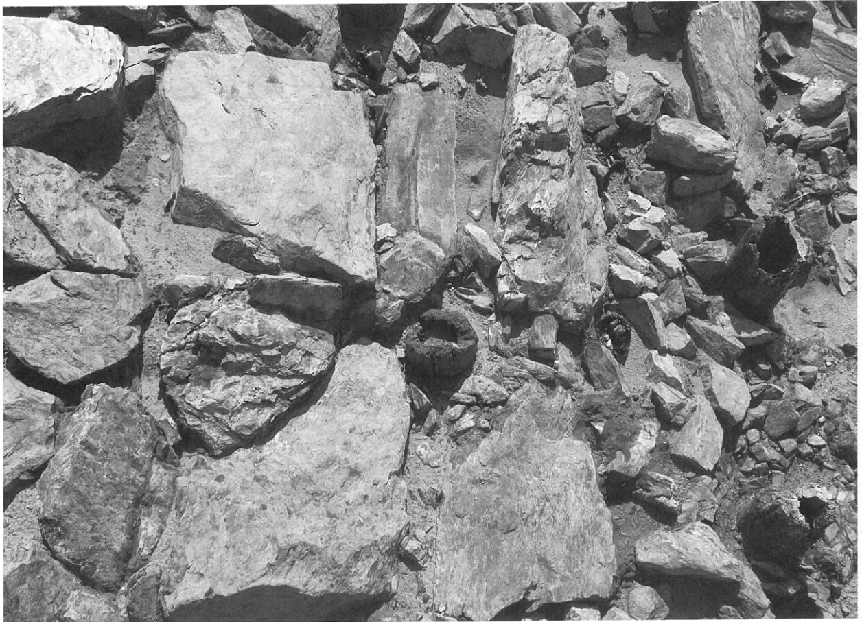
2. 護岸遺構 SX01 石積み状況 (部分)
