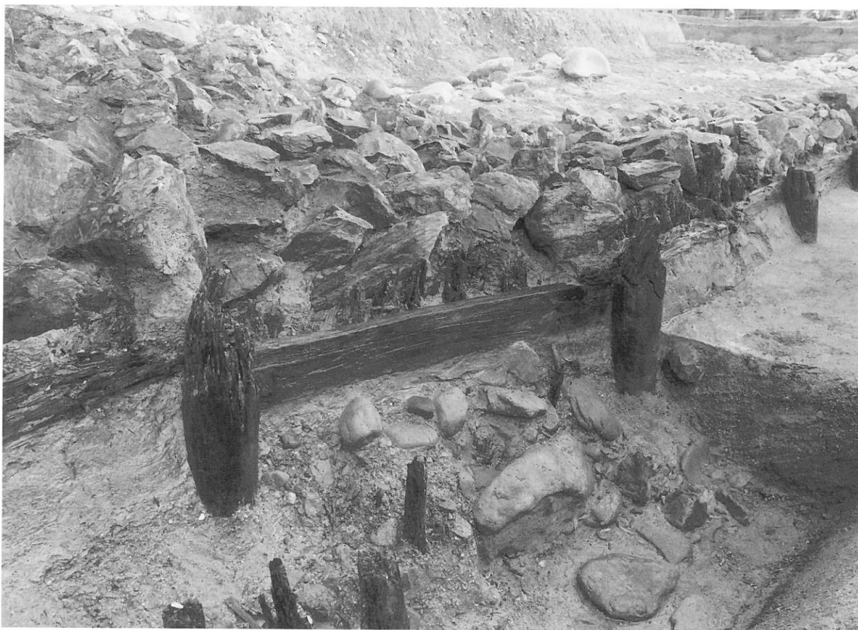
2. 護岸遺構 SX01 杭止め部分 (北西から)
