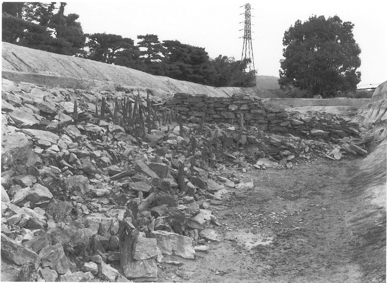
2. 護岸遺構 SX01 (北西から)
