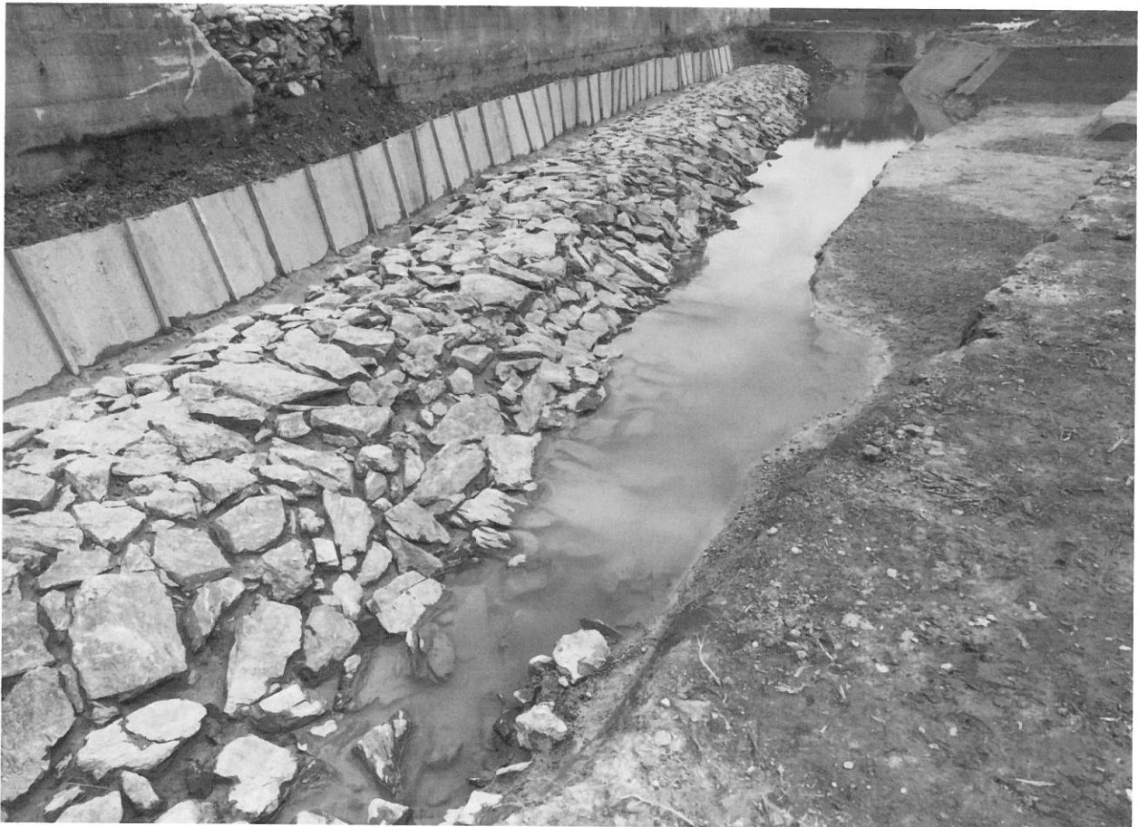
2. 護岸遺構 SX01 注水状況 (北から)
