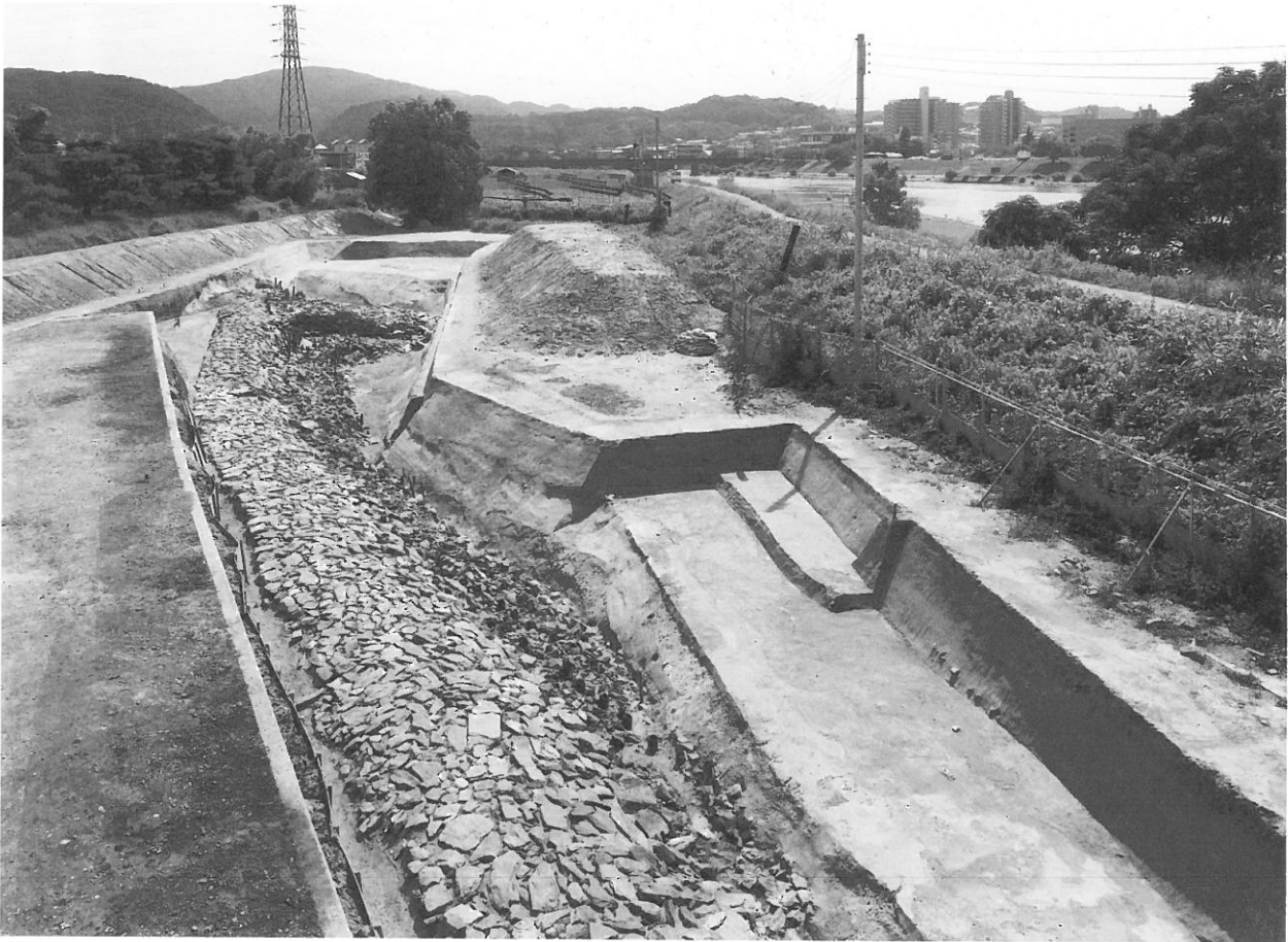
1. 護岸遺構 SX01 全景 (北から)
