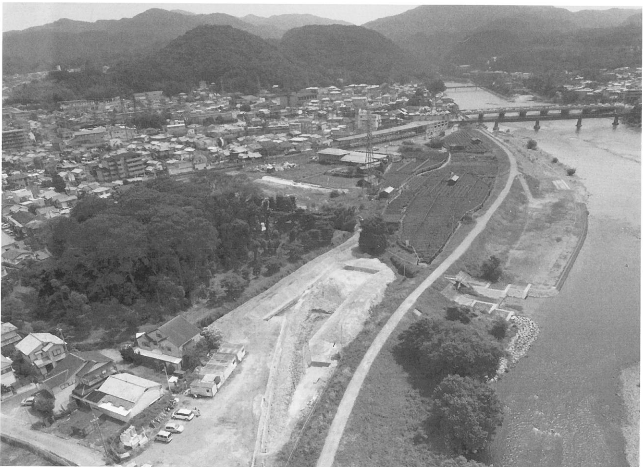
2. 調査地全景 (北西から)
