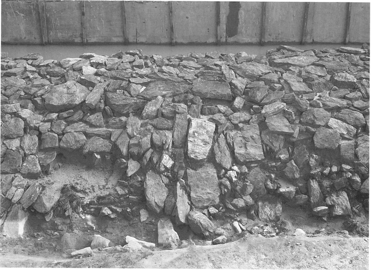
1. 護岸遺構 SX01 石張り状況 (西から)
