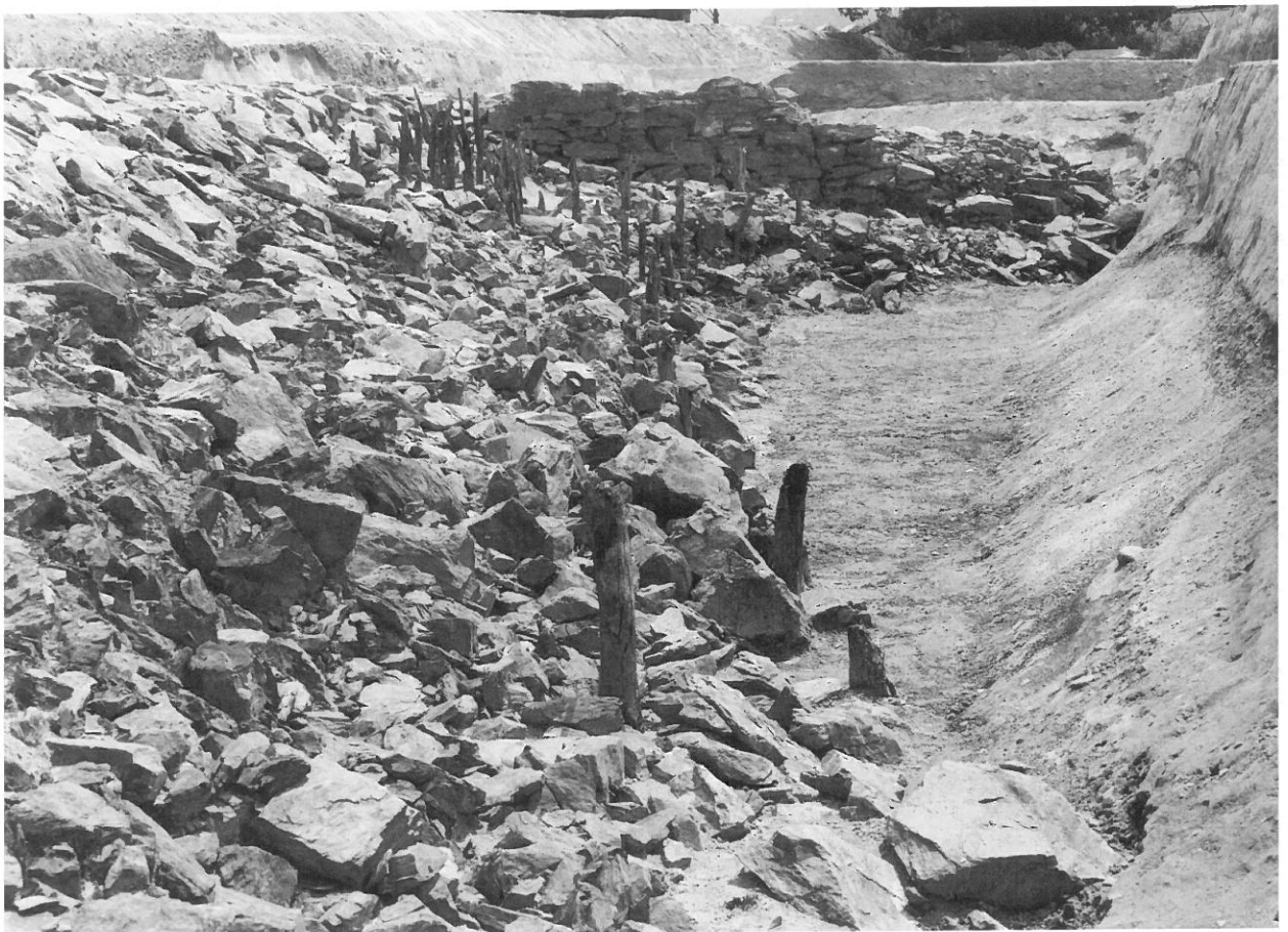
2. 護岸遺構 SX01 石積み状況 (北から)
