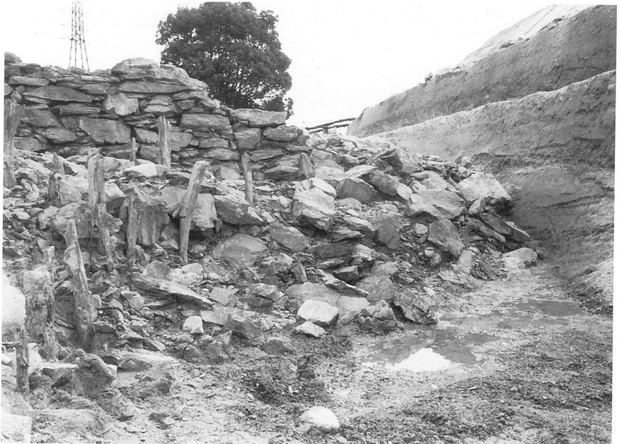
1. 護岸遺構 SX01 石出し 1 下流側崩落状況 (北から)
