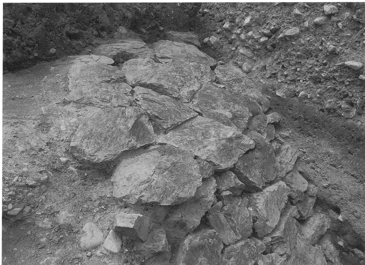
2. 護岸遺構 SX01 石出し 3 天端石張り (北東から)
