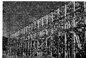
東宇治中学校校舎の増築工事
