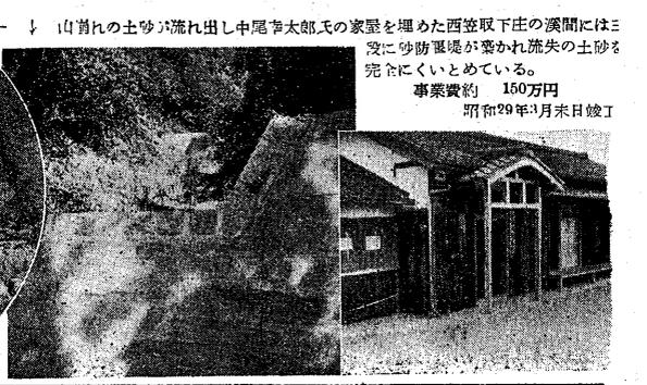
山崩れの土砂が流れ出し中尾草太郎氏の家屋を埋めた西笠取下庄の溪間には三段に砂防堰堤が築かれ流失の土砂を完全にくいとめている。
