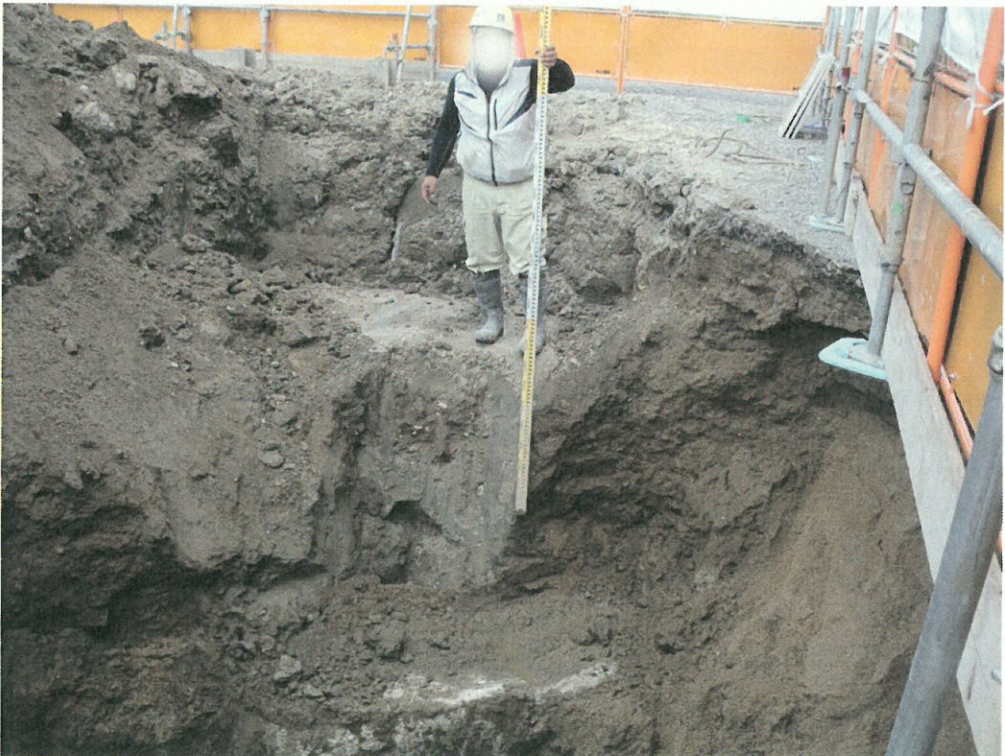
② 9月7日 埋設深さ確認 GL-2,000
