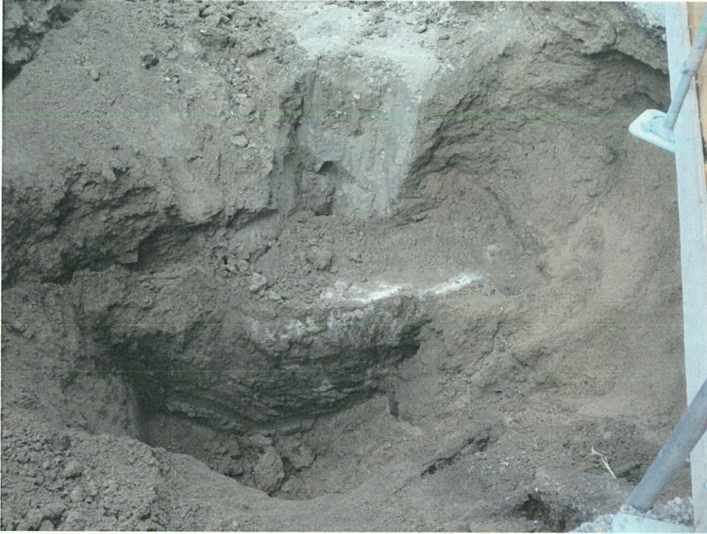
① 9月7日 地中障害物確認
