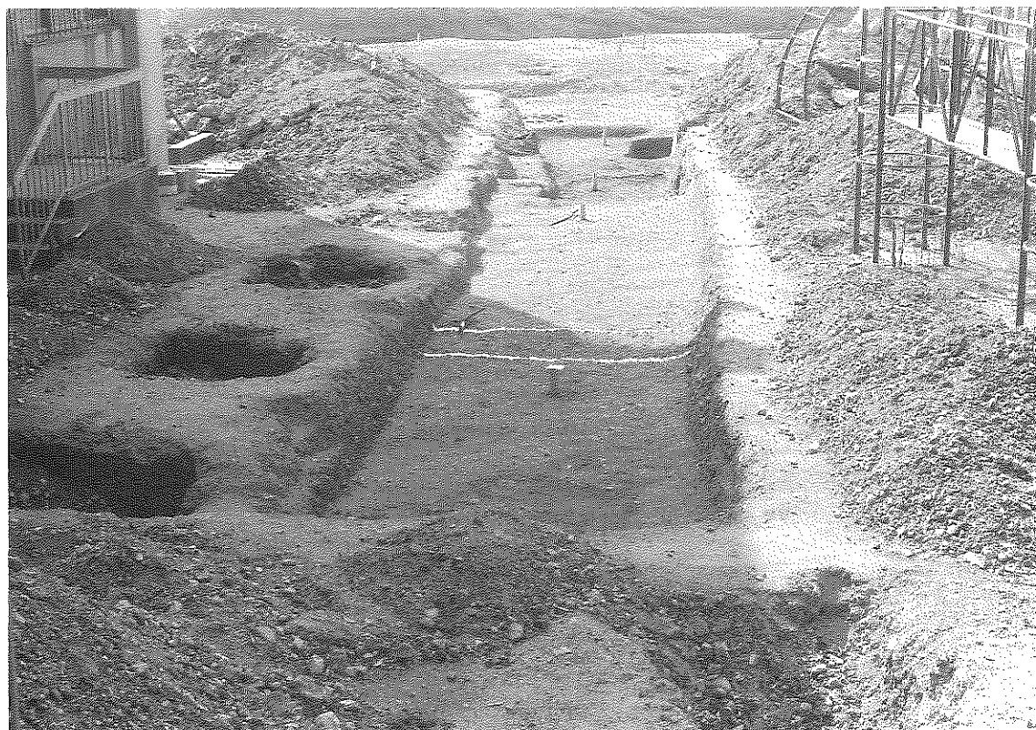
(2) 多宝塔基壇検出状況（東から）
