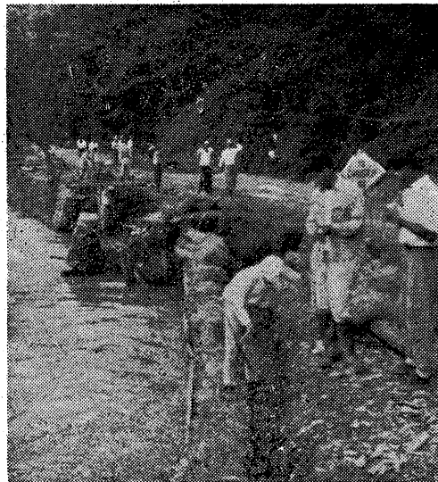
一観光道路の復旧を急ぐ一
