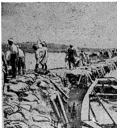
一水禍の根元決壊口の築堤作業一
