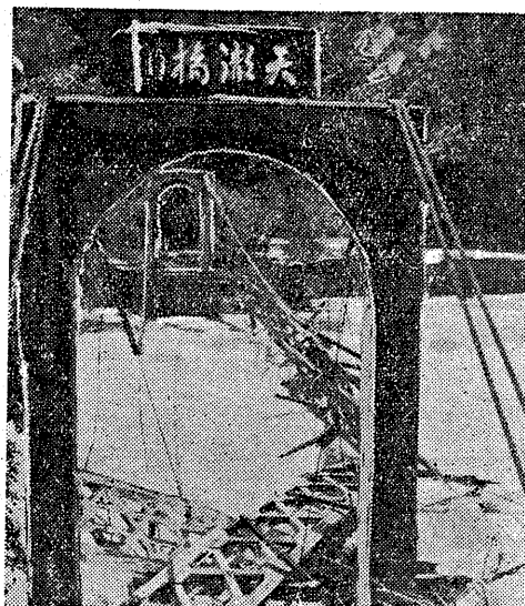
天瀬橋流失の惨状
