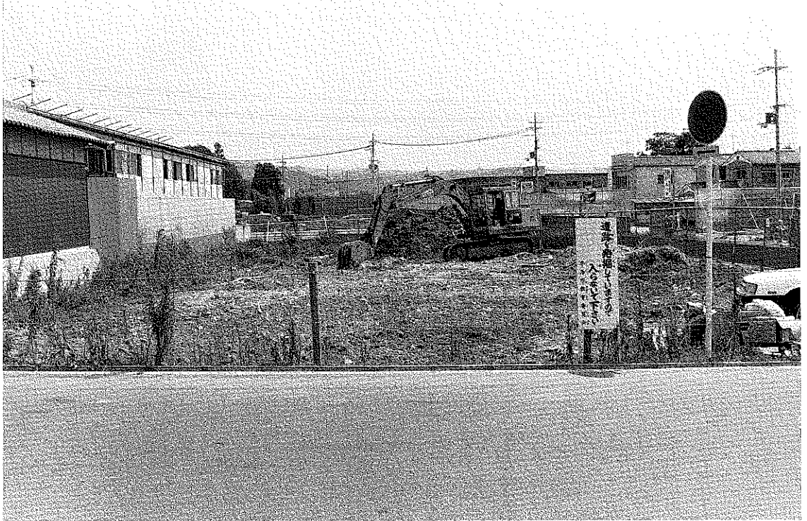
(1) 調査前の状況（北から）
