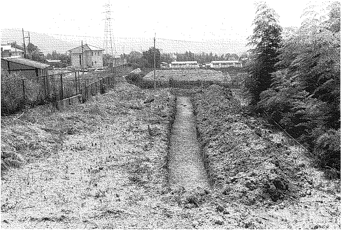
(1) トレンチ完掘状況（北から）
