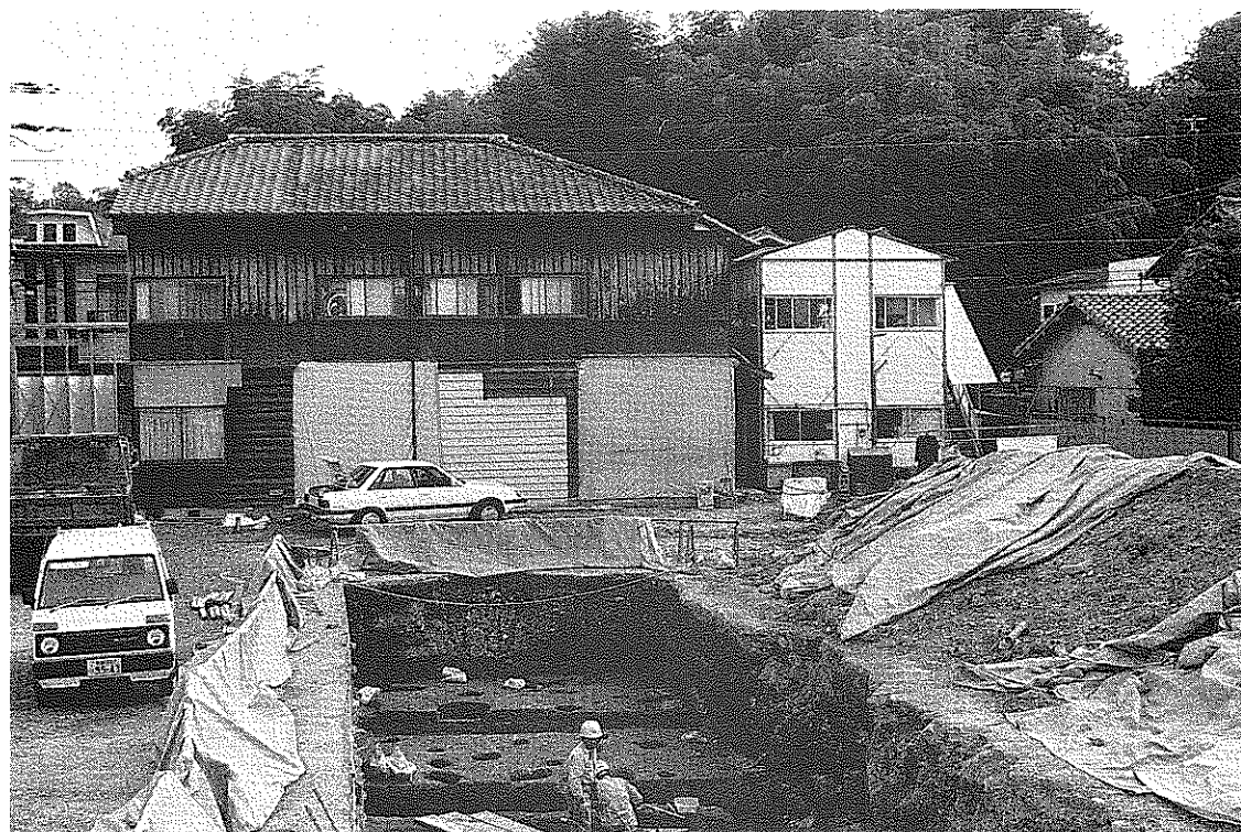
(2) 調査地の状況(北から)
