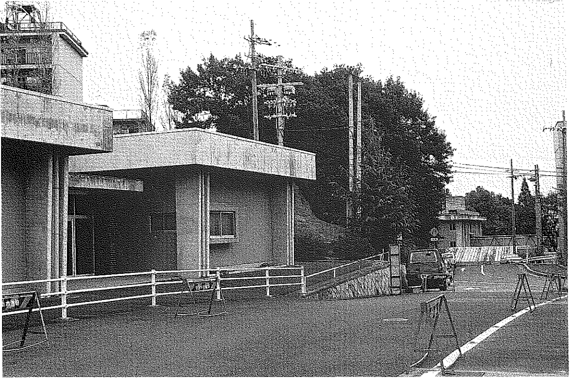
(1) 調査地の遠景（南から）
