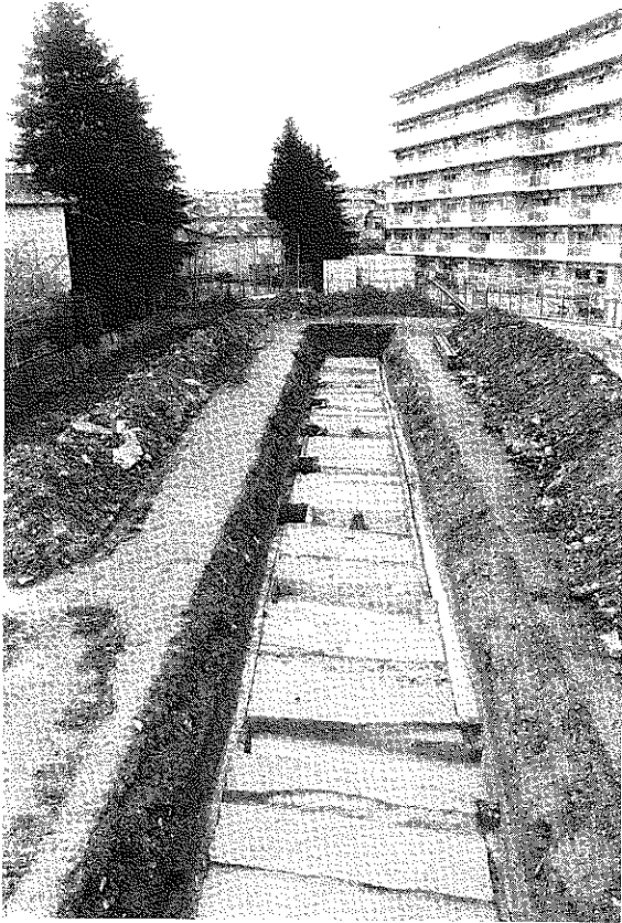
第16図 1 トレンチ全景 (北東から)
