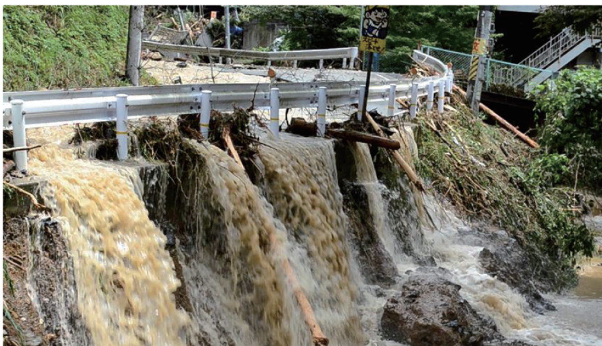
道路を流れる土石流（平成24年8月14日朝）
