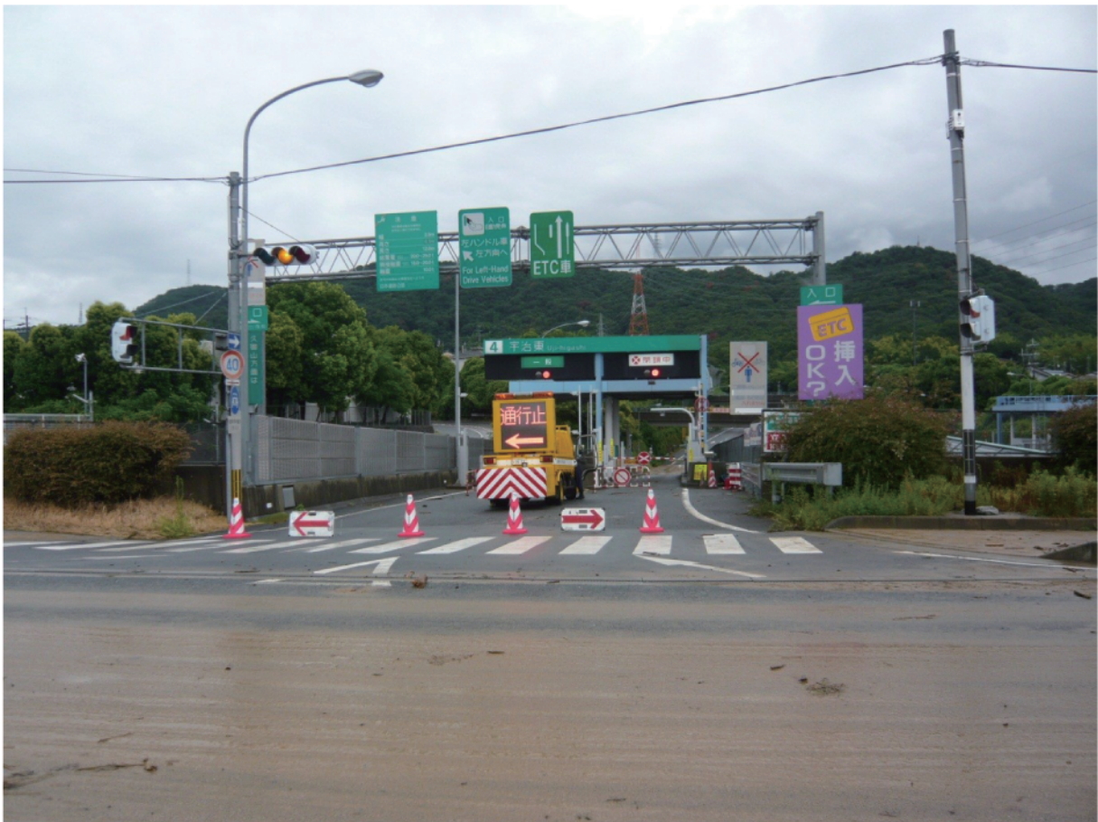
通行止めとなった京滋バイパス（平成24年8月14日8時頃）
