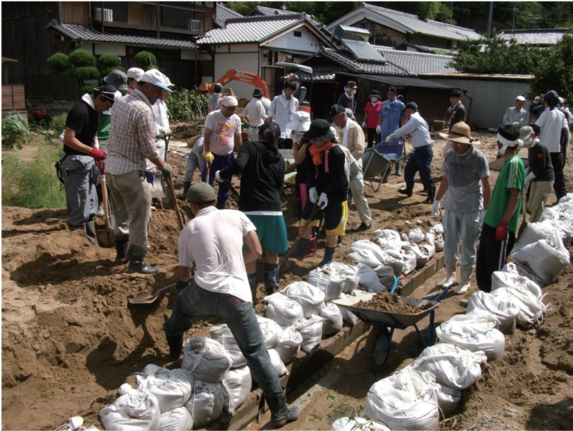
ボランティアによる作業（平成24年8月19日10時頃）
