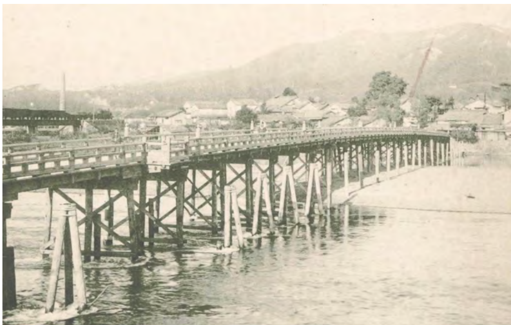
第 6-1 図 参考写真 宇治川左岸から京阪宇治駅方面 (撮影時期：明治 39～45 年)
