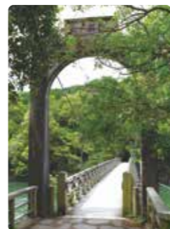
天ヶ瀬吊り橋
